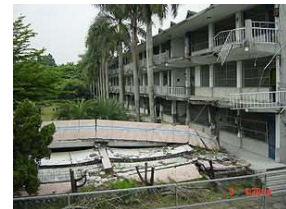
そのまま残存の被災中学校。露出大断層も保存し、周辺整備と合わせ 地震記念博物館に
